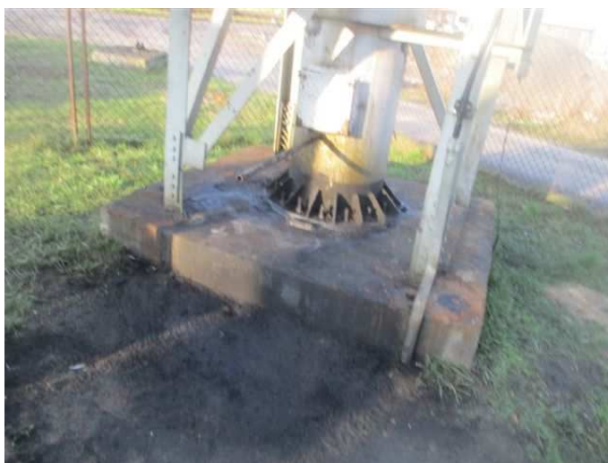
Fot. Fundament istniejącego komina przeznaczony do wyburzenia
