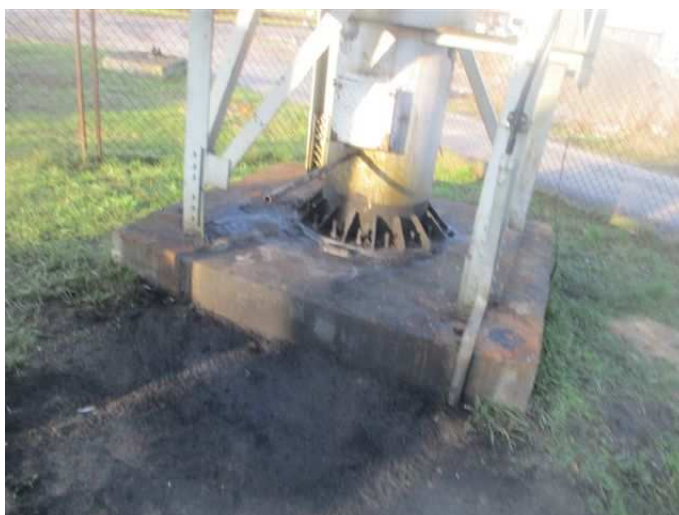
Fot. Fundament istniejącego komina przeznaczony do wyburzenia
