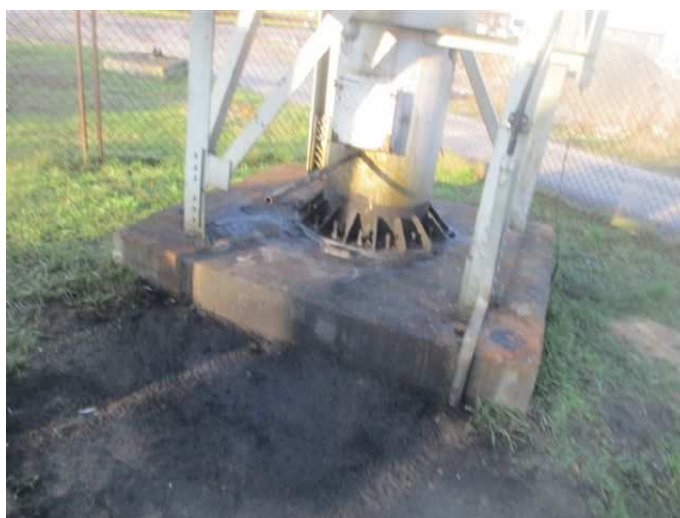
Fot. Fundament istniejącego komina przeznaczony do wyburzenia
